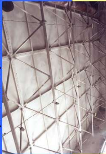
Покрытие из ПСЖ с использованием одиночных уголков
