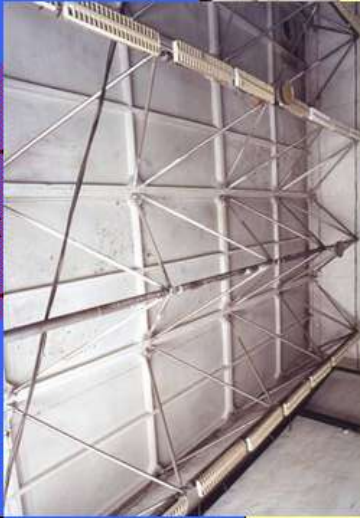
Покрытие из ПСЖ с использованием грубчатых элементов
